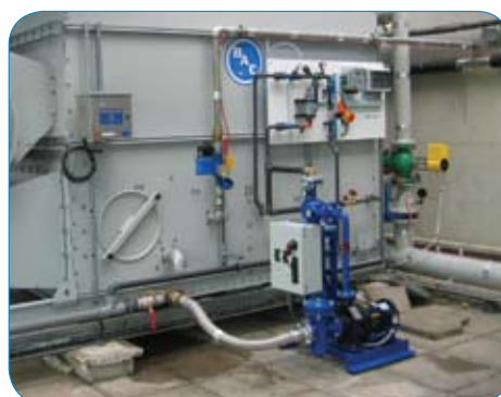
Installazione di sistema di filtrazione
