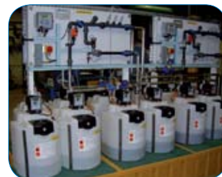
Installazione di BCP
