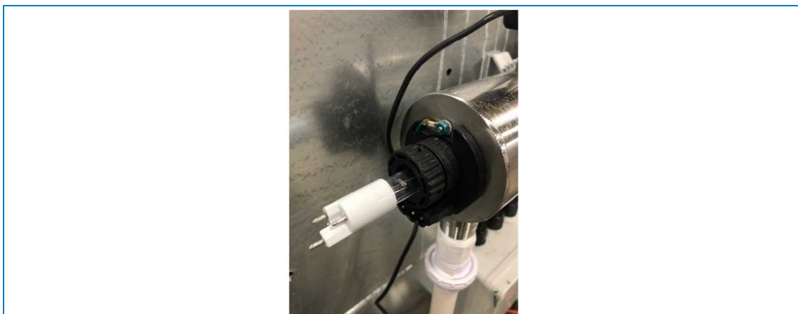
Снятие лампы с УФ-излучением
