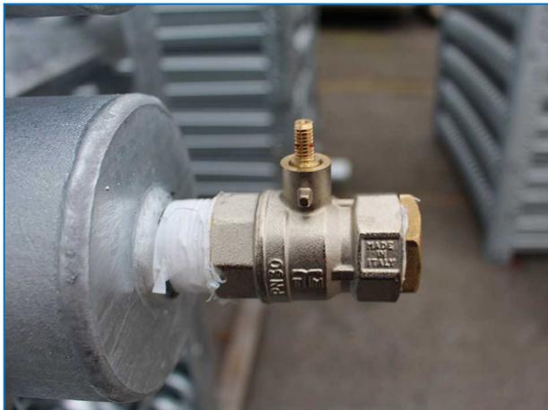
Oberer Rohrbündelanschluss mit Überdruckventil auf Verdunstungsverflüssigern.
