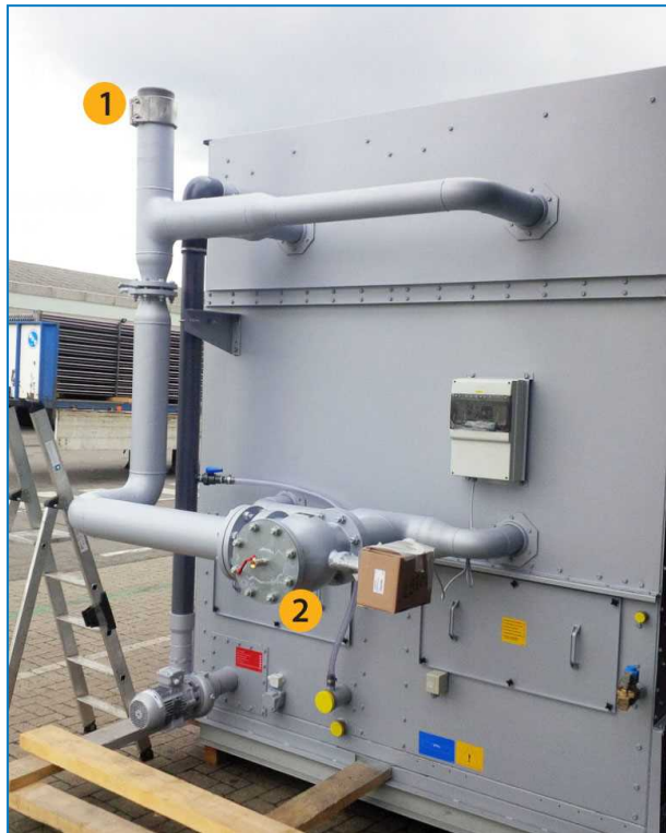
Gerät mit geschlossener Außenverrohrung
