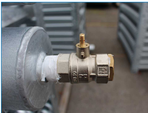
Oberer Anschluss des Rohrbündels mit Überdruckventil auf Kühltürmen mit geschlossenem Kreislauf und Anschlüssen größer als ND100.
