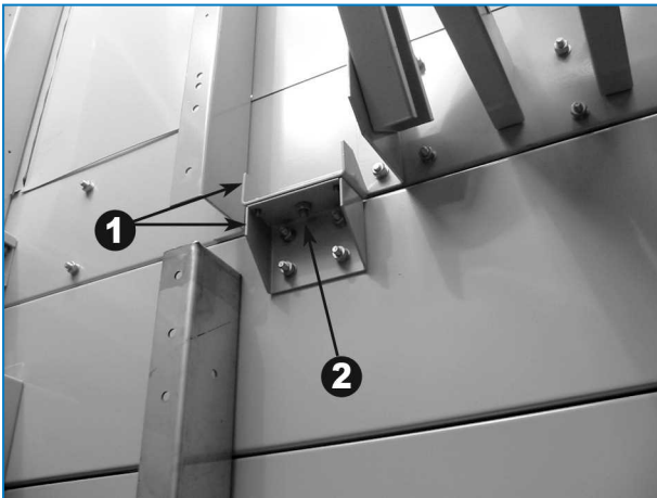
Sezione plenum installata su sezione inferiore
