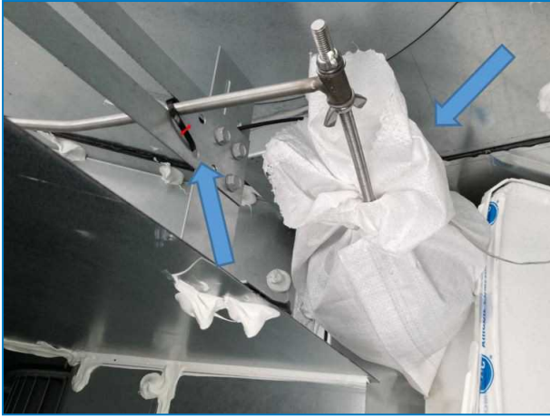
Fijación y envoltura del flotador de bola
