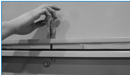
Utilisation des broches d'assemblage pour aligner les trous de vissage
