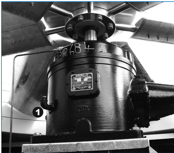
Motoriduttore a riduzione singola
