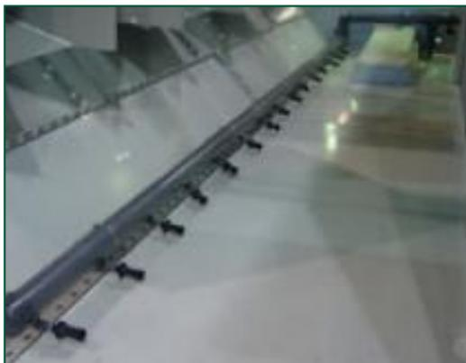
El sistema de filtración de la balsa **evita que los sedimentos se depositen en la balsa de agua fría** de la unidad. Se instala un sistema completo de tuberías, incluyendo pulverizadores en la balsa del condensador **para conexión a la unidad de filtrado**. [Siga leyendo](#)
